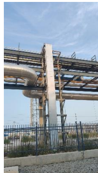
变电站进出线
